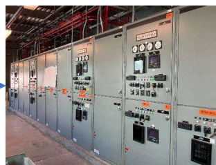
12kV Switchgear
