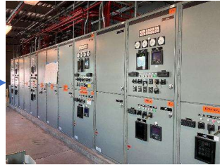
12kV Switchgear
