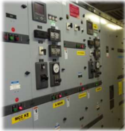
Blower Switchgear
